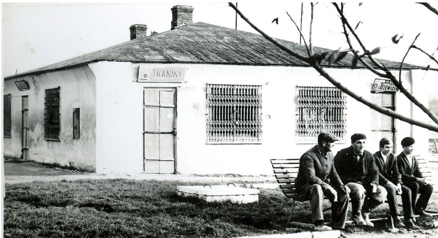
Rok 1970. Budynek dawnego ratusza w centrum Rynku Grabowca (nazywany czworobokiem albo murowanką). Przed II wojną światową były tu pomieszczenia handlowe, a po 1945 r., mieściły się tu także sklepy różnych branż Gminnej Spółdzielni „SCh” w Grabowcu. Budynek uległ pożarowi w nocy z 7/8 marca 1979 roku. Mury rozebrano i przeznaczono na naprawę dróg gruntowych na terenie gminy. Widok od strony zachodniej.
