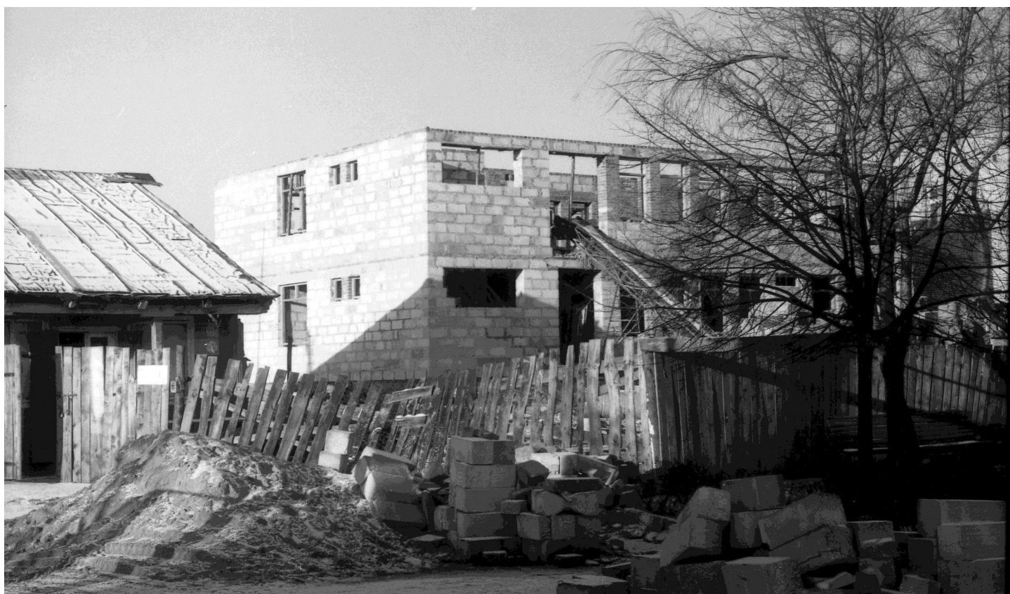
Rok 1978. Budynek administracyjny urzędu gminy w trakcie budowy (widok od strony rynku). Obok z lewej fragment drewnianego (przedwojennego) budynku po byłej restauracji „Kalinówka” i sklepie z art. do produkcji rolnej GS (pracował tu Adolf Samulak). Restaurację przeniesiono do nowego budynku który powstał w latach 1973-1975 i nazwano „Zamkowa” (pierwszy kierownik Wiesław Buczak). Sklep z art. do produkcji rolnej przeniesiono do piwnic pod magazynem rozdzielczym Gminnej Spółdzielni „Sch” we wschodniej części Rynku - gdzie funkcjonuje do dnia dzisiejszego (obecnie prywatny właściciel) .
