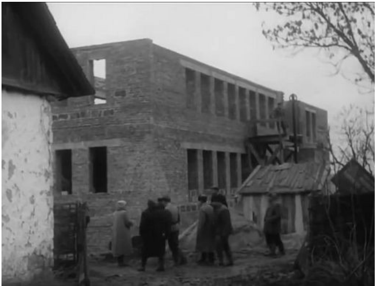
Na placu budowy. Widok od strony ul. Koziej. Dr Regina Boczkowska wraz ze Społecznym Komitetem Budowy Ośrodka Zdrowia - oglądają postęp prac na budowie. Kadr z PKF 1961 r.
