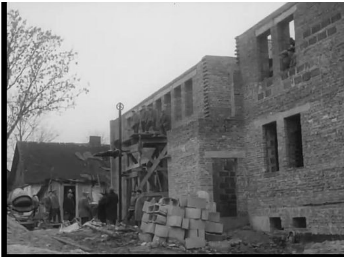
Na placu budowy. Widok od strony południowej. Widoczny przy Koziej budynek mieszkalny zostanie rozebrany. Dr Regina Boczkowska wraz ze Społecznym Komitetem Budowy Ośrodka Zdrowia - oglądają postęp prac na budowie. Kadr z PKF 1961 r.
