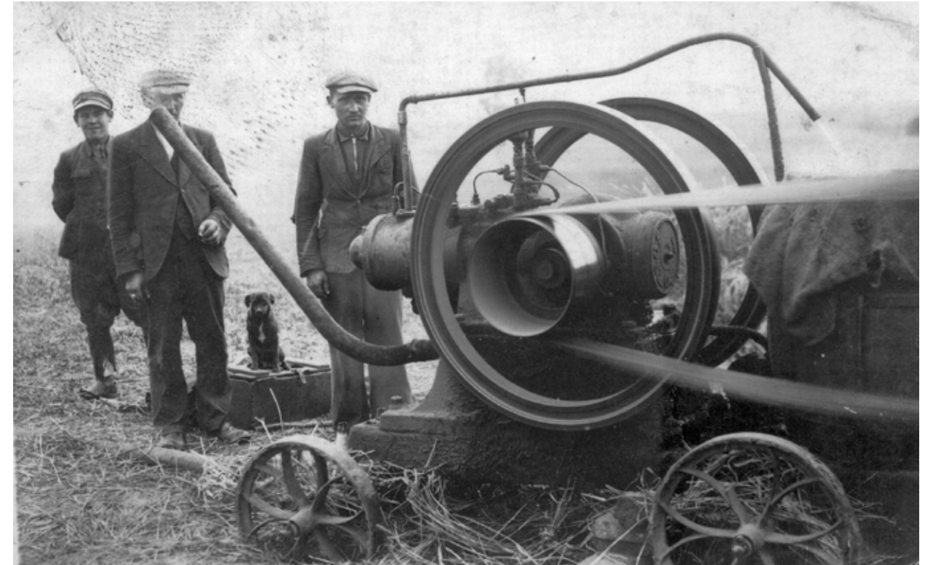
Rok 1936 (około). Młocka w Grabowcu. Na zdjęciu silnik napędzający młocarnię i jego obsługa. Jest to silnik polskiej produkcji firmy „PERKUN” z Warszawy w roku 1910. Silnik mógł być napędzany olejem napędowym, naftą albo spirytusem. Fot. Leon Sokołowski.
