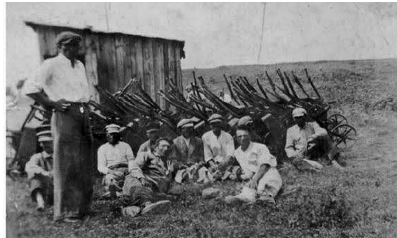
1941. Ostrówek. Budowa drogi Grabowiec-Hrubieszów, robotnicy podczas pory obiadowej. Zdjęcie udostępnił Marek Ryś.
