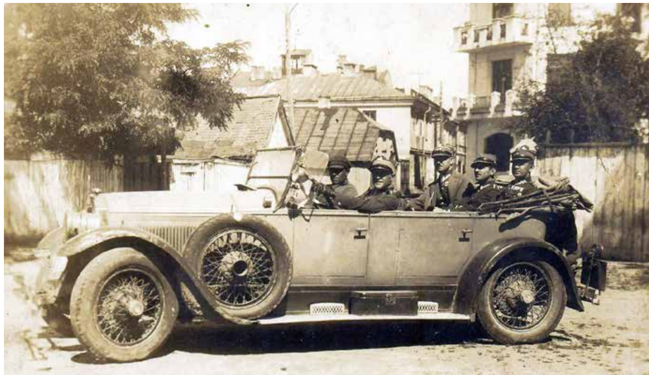
Rok 1927 w Zamościu. W samochodzie kadra oficerska. Za kierownicę usiadł generał aby być lepiej widocznym na zdjęciu. Kierowca (szofer) siedzi obok. Jest to Mercedes 15/70/100 PS, 15/70/100. 100 KM, sześciocylindrowy silnik z doładowanym silnikiem o mocy 3920 cm 3 , czterostopniowa manualna skrzynia biegów, solidna oś przednia i tylna oś pod napięciem z półeliptycznymi resorami piórowymi oraz mechaniczne hamulce bębnowe na cztery koła. Rozstaw osi: 3630 mm. Zdjęcie ze zbiorów Janusza Koremskiego.
