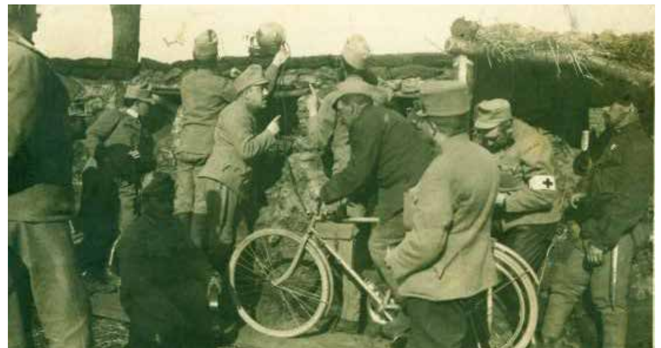
Rok 1915 (lub 1916). W austriackich okopach. Zdjęcie ze zbioru Janusza Koremskiego. Żołnierz korzystają z telegrafu świetlnego zasilanego prądnicią napędzaną rowerem.
