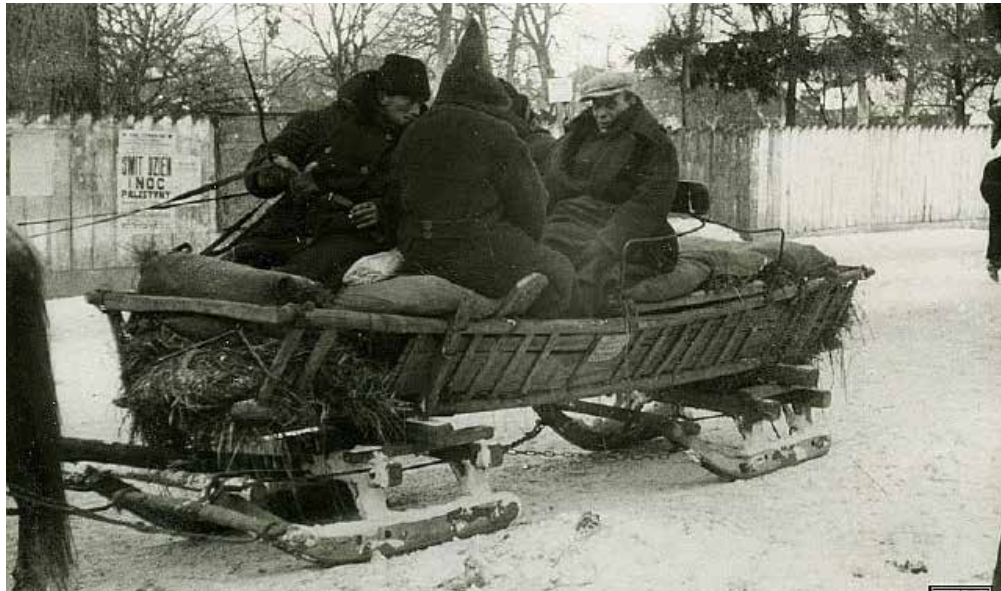
Rok 1949. W drogę. Sanie-uczęściowe tzw. zajdki - o podwójnym podsaniu łączonym łańcuchem, mniej popularne na naszym terenie. Na tego rodzaju sanie można było zamontować wasąg (skrzynię) taki sam jak na wóz konny. Tego typu sanie były także wykorzystywane do wozienia długich pni drewna. Podsanki spinano łańcuchem na krzyż, co pozwalało na dobry skręt (widać to na zdjęciu). (Zdjęcie z Internetu).
