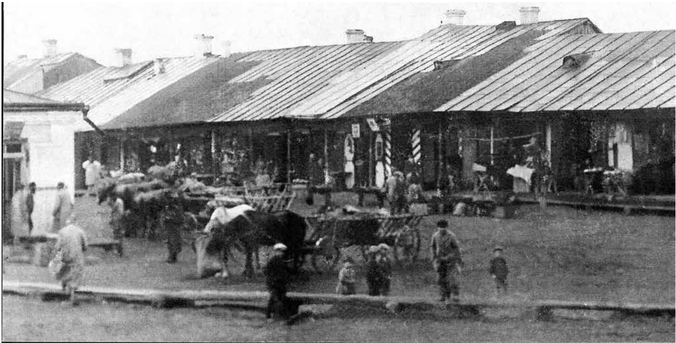
Południowa część rynku w Grabowcu. Z lewej, fragment tzw. "murowanki" - widoczne drzwi i szyld, są od strony zachodniej. Jak pamiętam, przed spaleniem się tego budynku, mieścił się tu sklep agd GS w którym pracowała p. Regina Jeziorkowska. Widoczna drewniana kładka łączyła sklepy po stronie zachodniej rynku.
