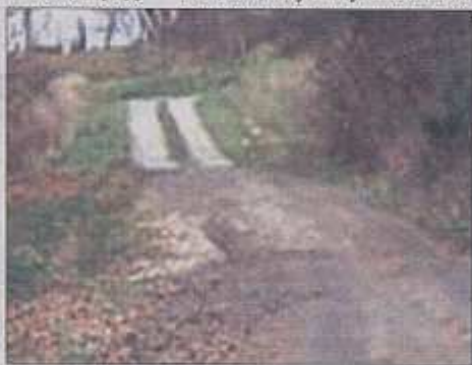
Zamiast asfaltu – betonowe płyty, gruz i żużel.
