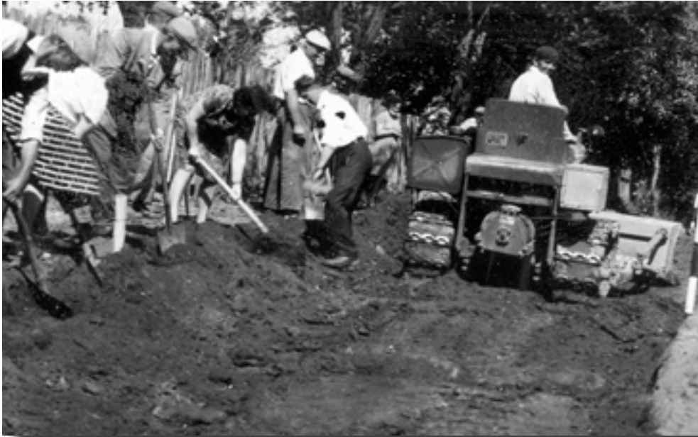
Zdjęcie 50 Roboty przy dojeździe do budynku Ośrodka Zdrowia 1962 rok.
