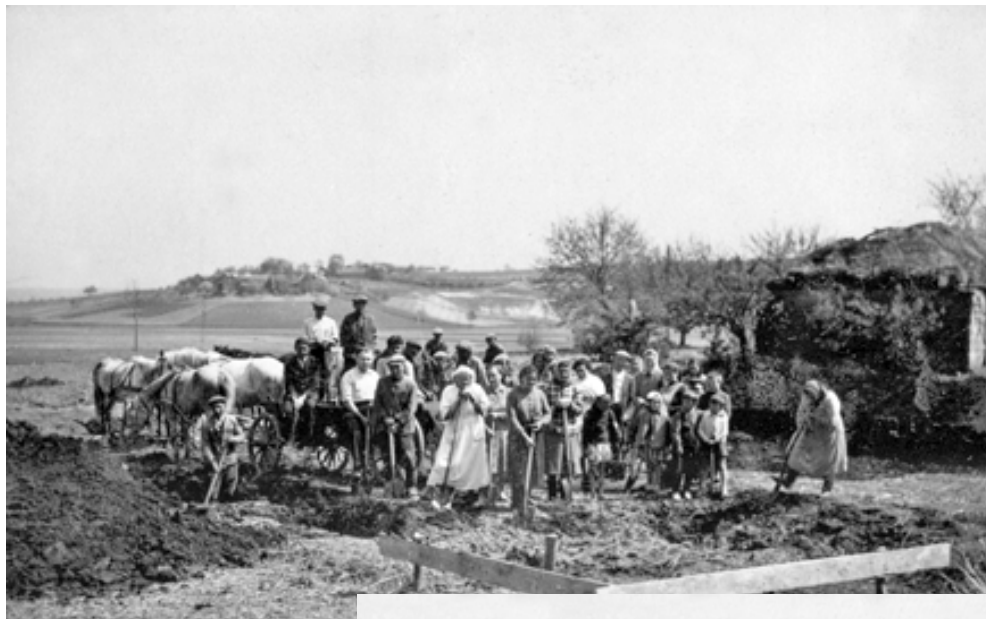
Zdjęcie 47 Praca ludności przy wykopach na fundamenty budynku Ośrodka Zdrowia – 1959 rok.
