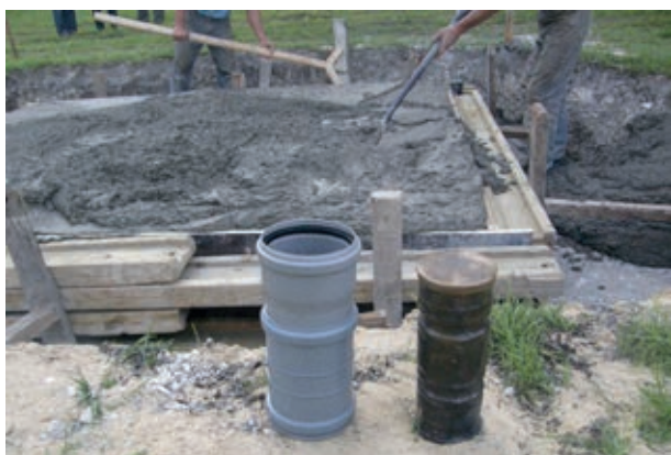
Sierpień 2011 r. Budowa fundamentu pod pomnik. Nz. kapsuła z aktem erekcyjnym. Zdjęcia Stanisław Senkowski
