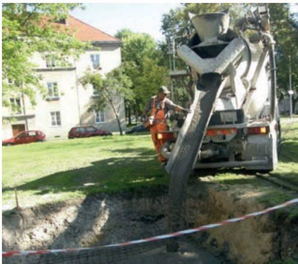
Sierpień 2011 r. Zalewanie fundamentu pod pomnik
